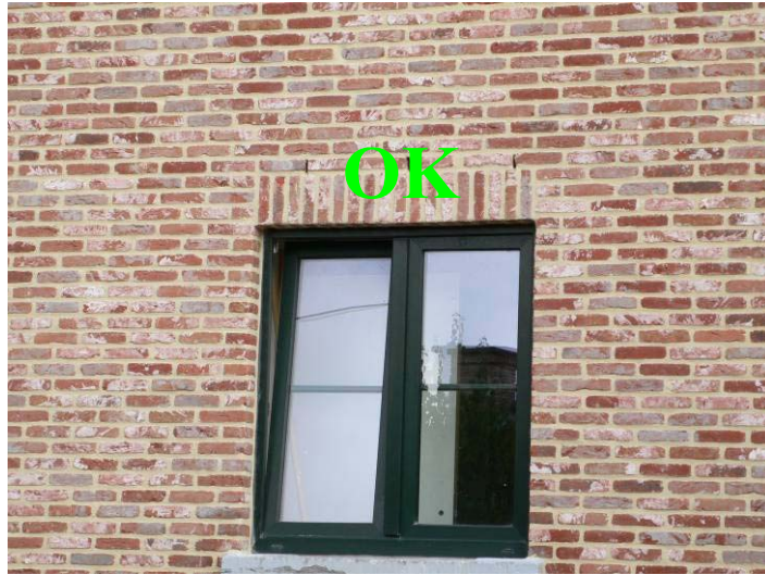
Bon exemple de teinte de briques anciennes et joints bien beurrés
