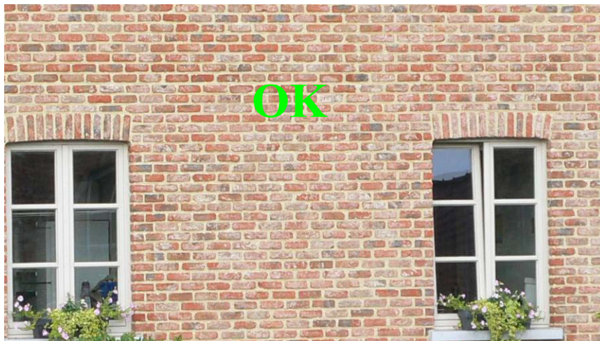
Bon exemple de teinte de briques anciennes et joints bien beurrés
