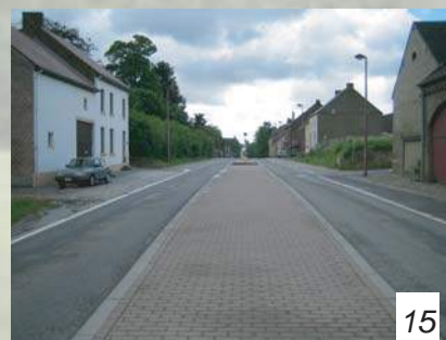
Entre certains îlots , le terre plein est matérialisé par des dalles.
