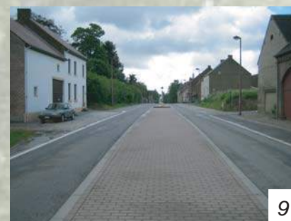
Le bâti bordant la traversée constitue malgré tout des éléments de petit patrimoine.
