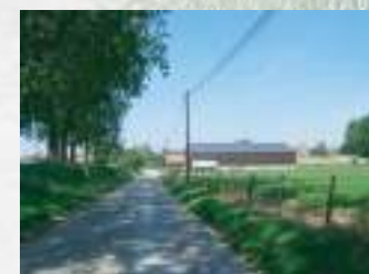
Les abords de la voirie sont en zone constructible tandis que les prairies à droites sont affectées en ZACC. A l'heure actuelle, le hangar pourrait faire l'objet d'une meilleure intégration.
