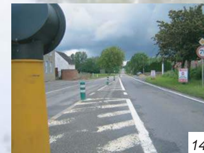
Les extrémités des îlots sont prolongées par un marquage au sol et des potelets en plastique.
