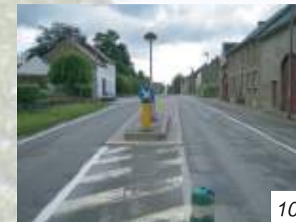
Les trottoirs sont, par endroits, inexistant.
