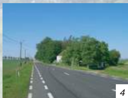
Traversée de la nationale N29, lieu potentiel d'intervention.
