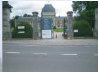
Situation actuelle : le bâtiment est peu visible.
