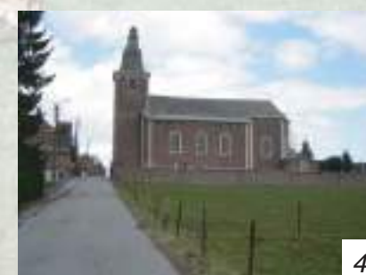
4 L'église Saint Jean-Baptiste constitue un point d'appel important surplombant le site
