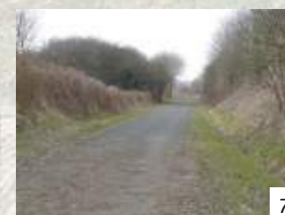
Le RAVeL se retrouve par endroit enclavé entre deux talus plantés
