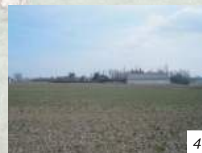
Le hangar communal au sud est de la ZACC a un impact visuel fort et constitue un point d'appel
