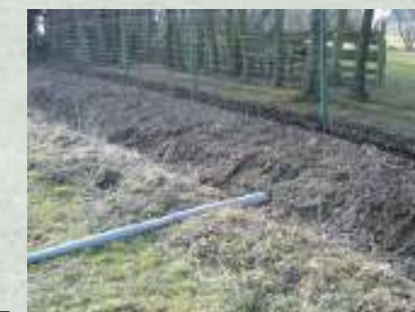
Branchements illégaux d'assainissements à supprimer
