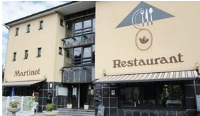
Ancien Hôtel Martinot (Martelange) = 9 logements seniors RDC = resto avec prix accessibles
